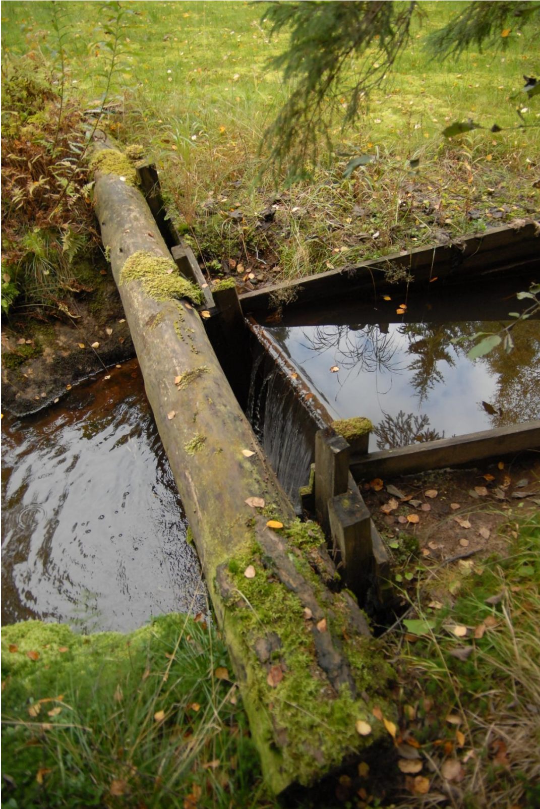
Kuva 175. Vesanojan kuudennen kohteen alempi pato.
