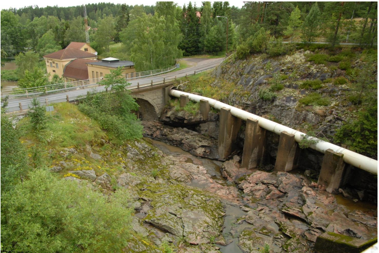
Kuva 44. Juvankoskea padolta alavirtaan kuvattuna. Sillan alapuolella on voimalaitos.
