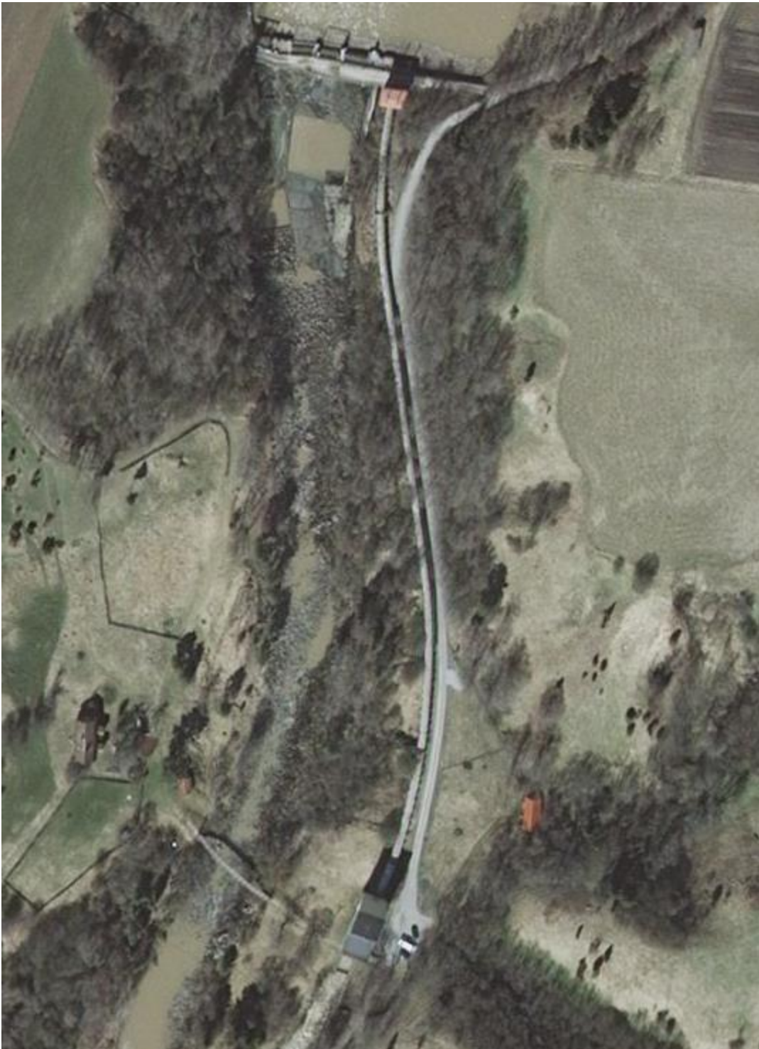
Kuva 17. Ilmakuva Askalan voimalaitoksen alueesta.
