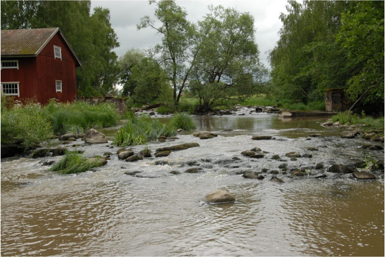
Kuva 59. Kosken yläosassa on ollut mylly, jonka padon jäänteet näkyvät uoman reunoilla.
