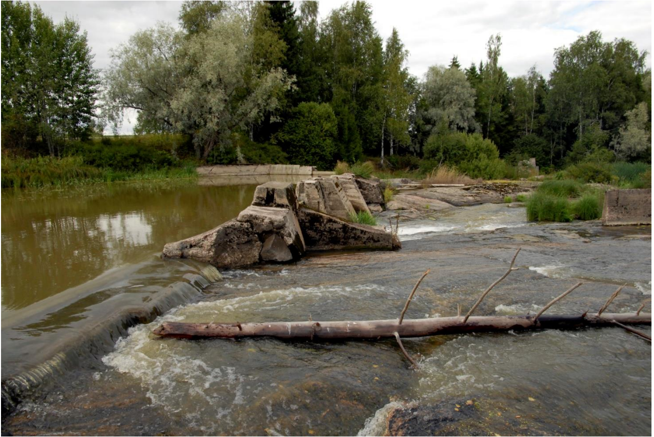
Kuva 85. Tuimalankosken pato vuonna 2010.
