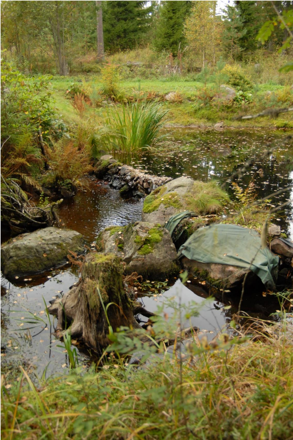
Kuva 180. Vesanojan yläosan uimalammen pato.
