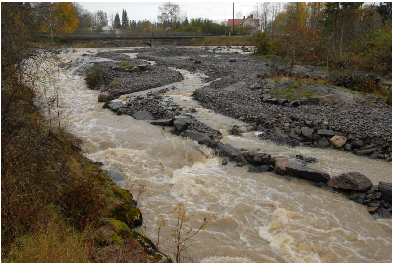
Kuva 86. Tuimalankosken pato vuonna 2012.
